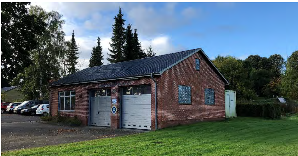
Abbildung 56: Feuerwehrgerätehaus Ulsnis (Quelle: eigene Aufnahme, 2021)
