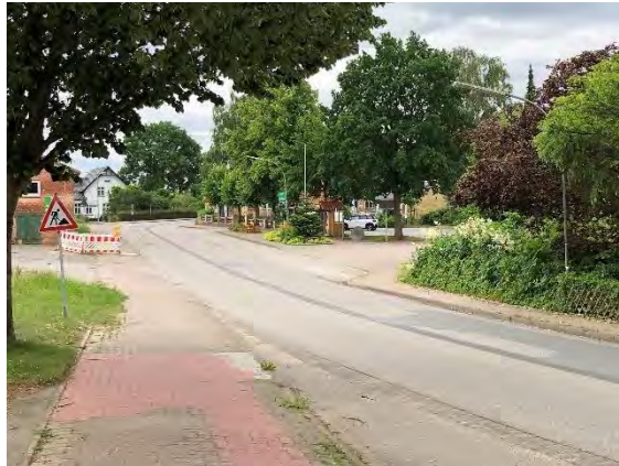
Abbildung 25: Straßen und Fußweg, Ulsnis (Quelle: eigene Aufnahme, 2021)
