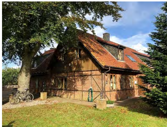
Abbildung 34: Dorfgemeinschaftshaus Nies Spuk, Loit (Quelle: eigene Aufnahme, 2021)
