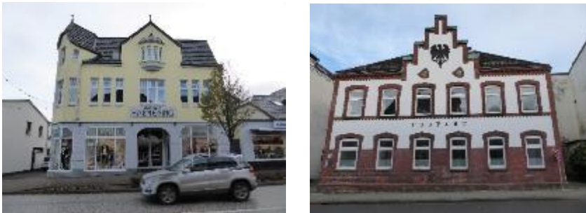
Foto 6: Beispiele für gut erhaltene ortsbildprägende Bausubstanz
