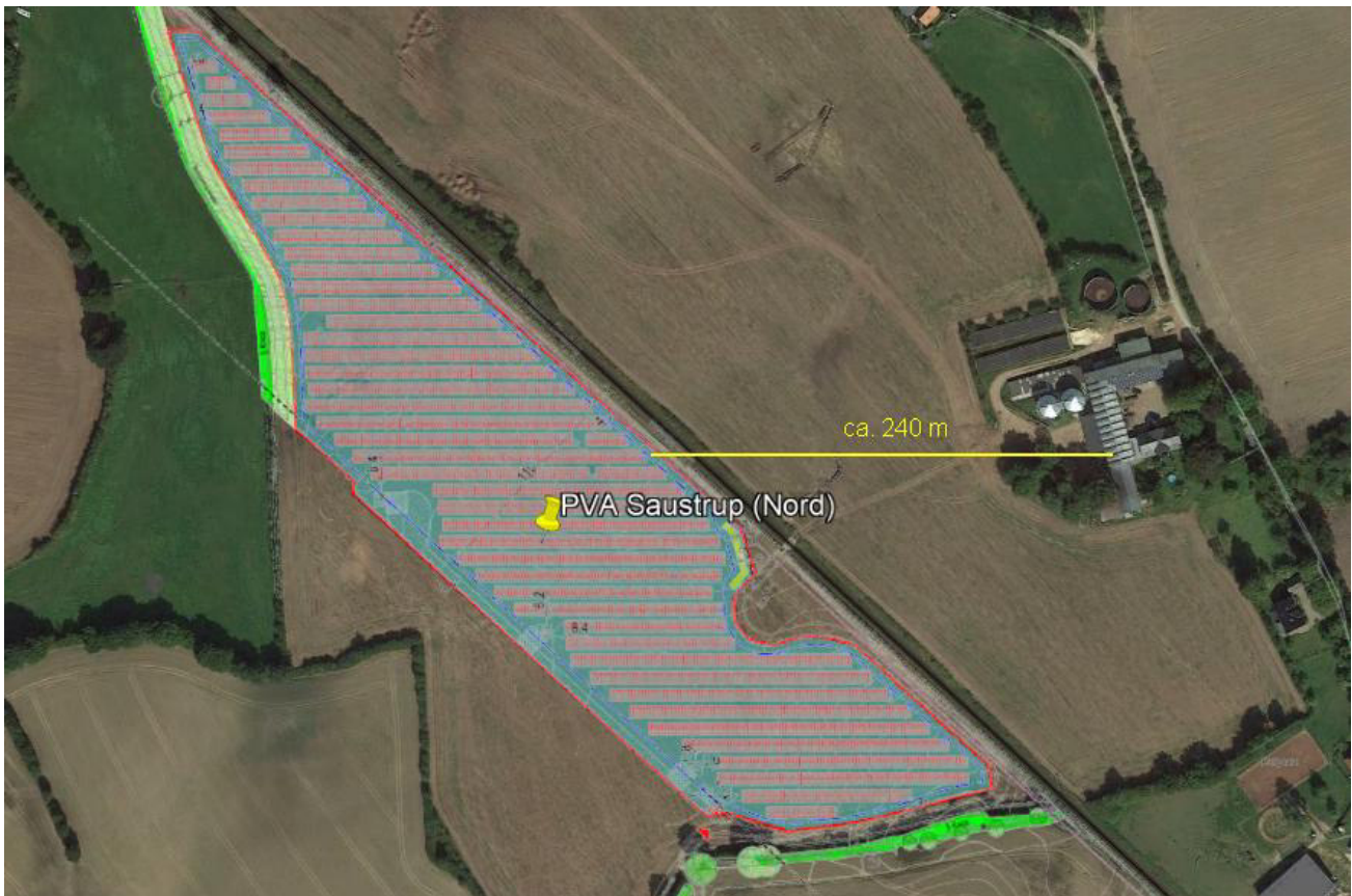
Bild 2.2.1: Gebäude im Bereich der PV Anlage Teilfläche Nord (Quelle: Google Earth/SolPEG)
