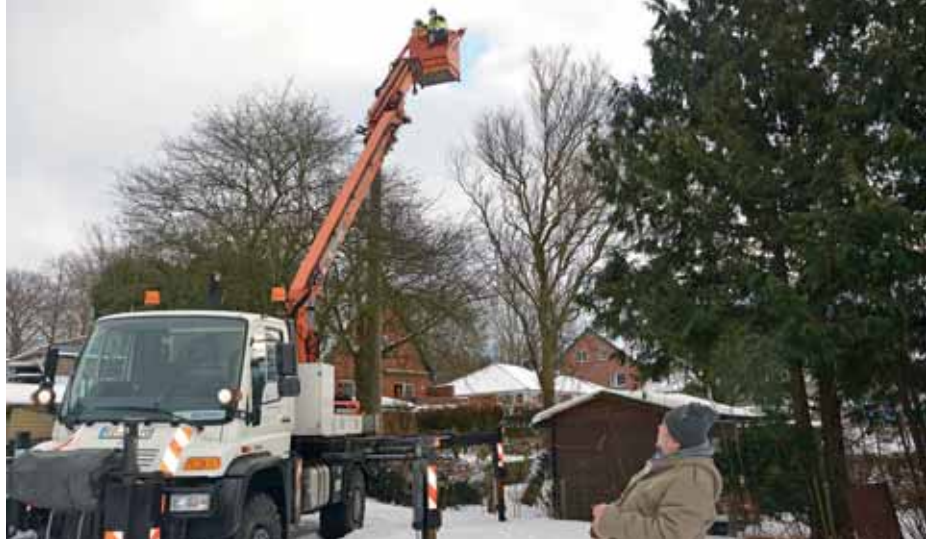
Uwe Petersen (r.) beobachtet die Arbeiten von Thomas Henningsen und Felix Dischereit in luftiger Höhe
