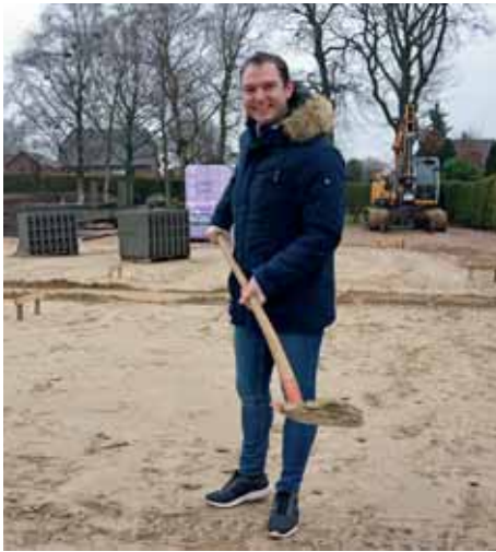
Christian Hansen macht den ersten Spatenstich für das Neubauprojekt
